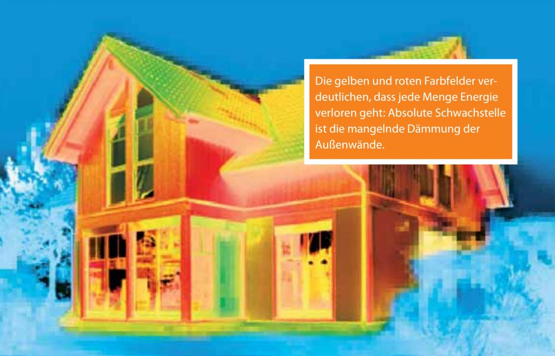
Die gelben und roten Farbfelder verdeutlichen, dass jede Menge Energie verloren geht: Absolute Schwachstelle ist die mangelnde Dämmung der Außenwände.
