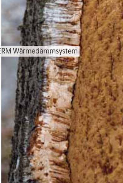
Dämmplatten aufgrund ihrer hohen Diffusions-offenheit und sehr guten Dämmwerten, hervorragend geeignet. Das Dampfdiffusionsverhalten ist optimal, so daß die Feuchtigkeit aus dem Mauerwerk bzw. aus den unteren Schichten des Systems jederzeit nach aussen abgegeben werden kann, wobei der Oberputz Schlagregenfestigkeit, Absicherung bei Frost-Tau-Wechsel und damit maximalen Klimaschutz garantiert. Richtlinien werden in der EN 13170 sowie der ÖNORM B 6000 definiert.
